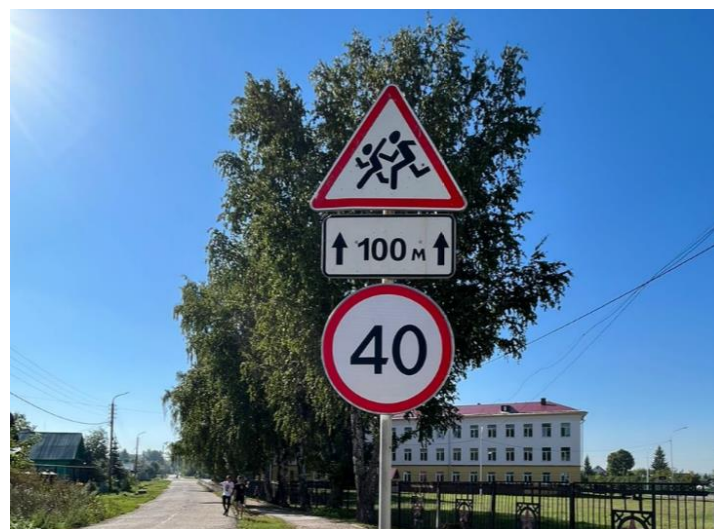
Установлено и заменено 1 544 дорожных знаков
