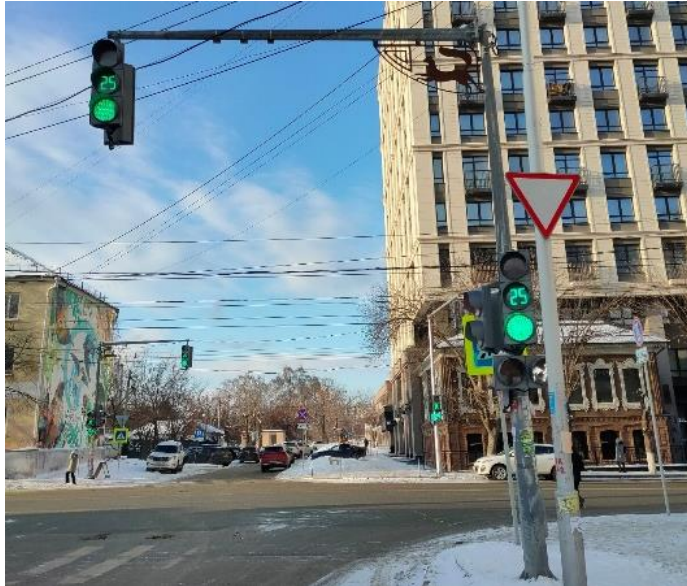
Установка 8 и модернизация 6 светофорных объектов
