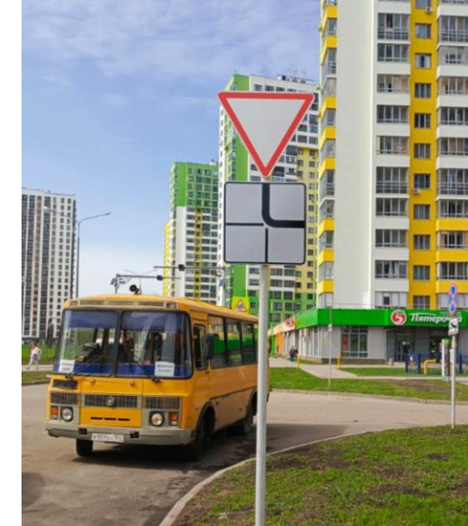
Установка и замена порядка 300 дорожных знаков
